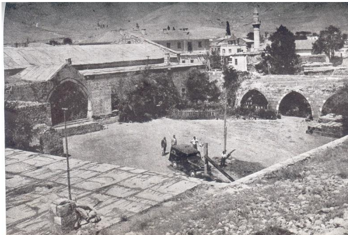
Resim 4. Ulukışla Öküz Mehmet Paşa Kervansarayı
