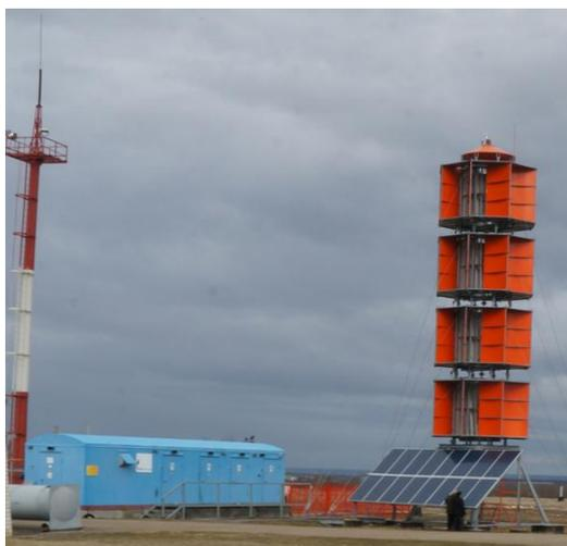
Рисунок 5 Ветро-солнечно-дизельный комплекс «Буран». Мощность ВЭУ-3,2 кВт, мощность солнечной установки 3 кВт, мощность дизель-генератора 10 кВт.
